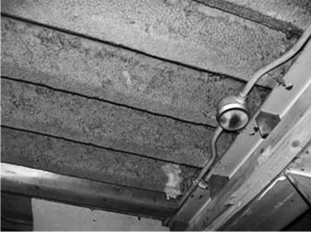
図5 鉄骨板に吹き付けられたアスベスト
